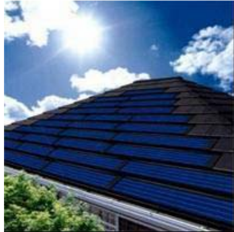
金属成型屋根 + PV 屋根
