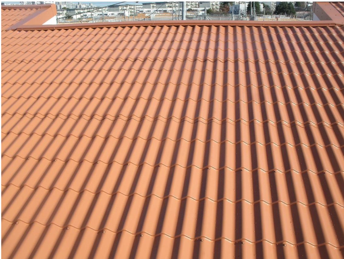
写真2 カラーエコガルで成型した縦葺長尺金属瓦「JFEルーフ プレーゲル」
