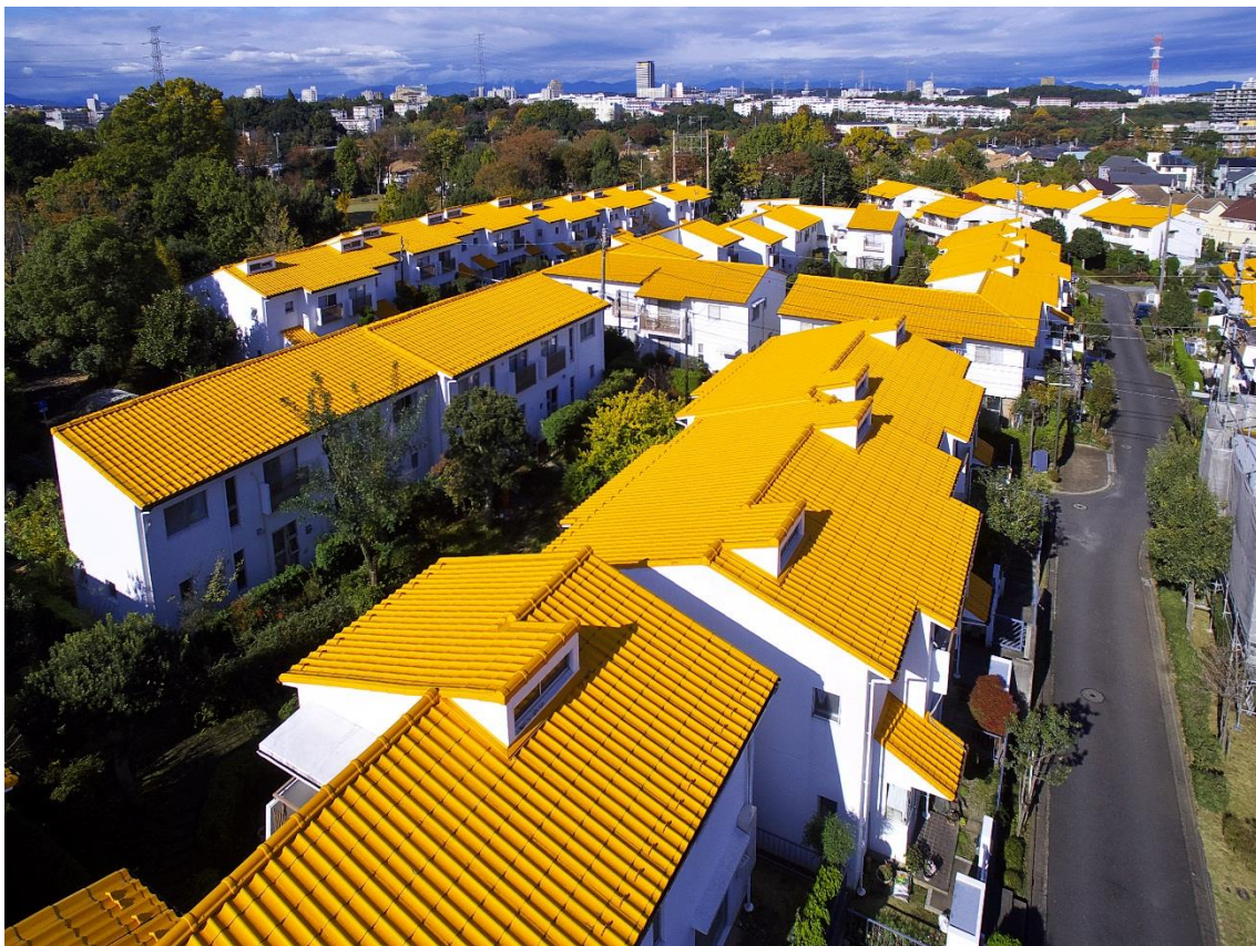
写真1 ドローンで撮影した施工前のタウンハウス永山の屋根群
