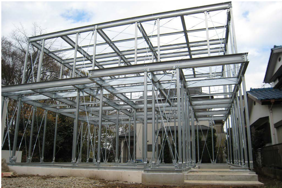
「フレームキット」外観（施工写真）
