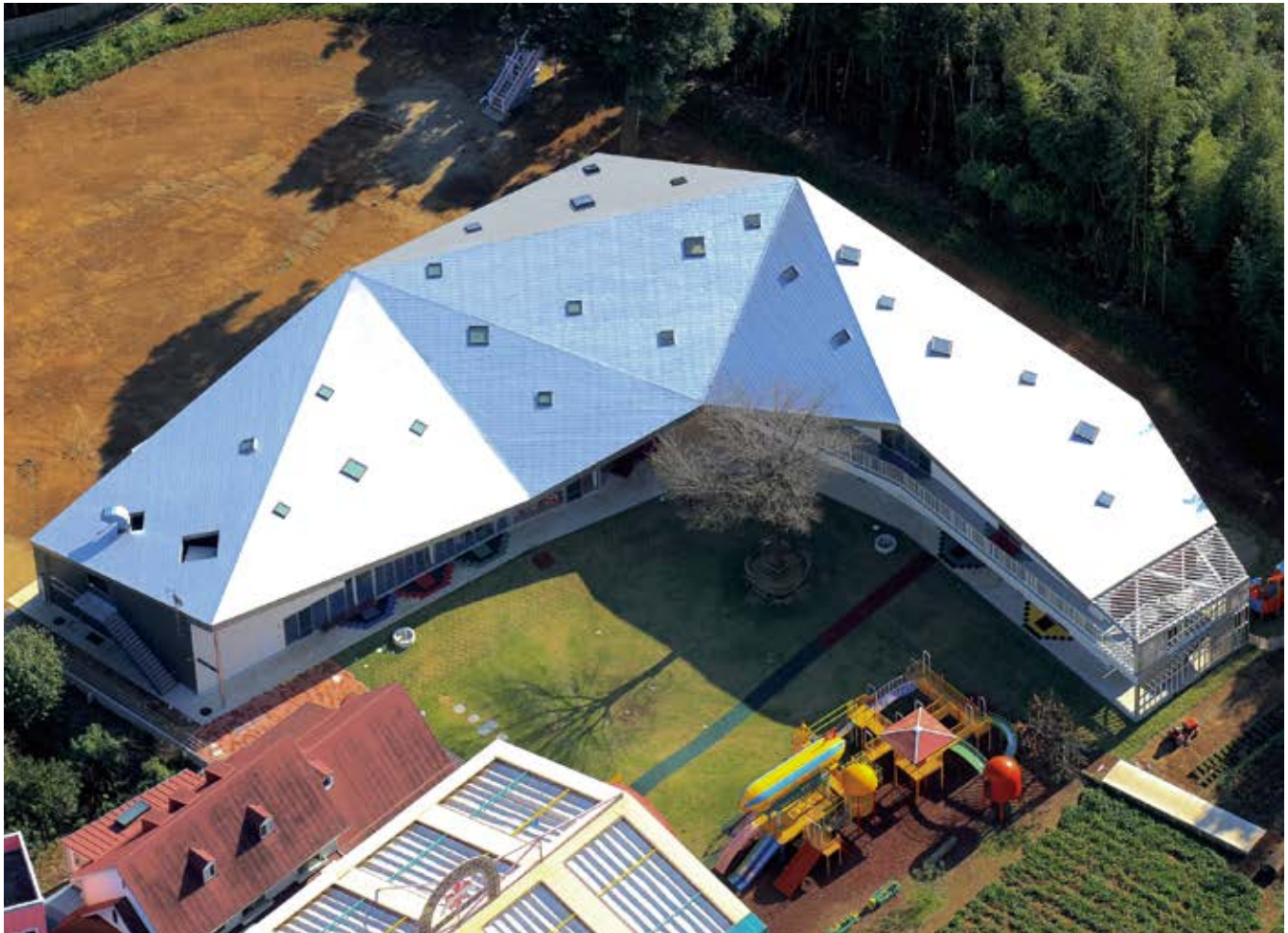
印西しおん保育園／大賀行雄建築設計事務所
