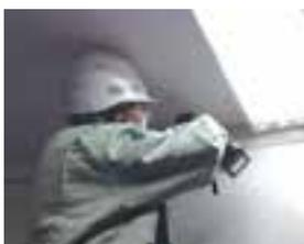
⑤枠材をビスで固定します。下部はビューボードに大きめの孔をあけ、遊びを設けます。
