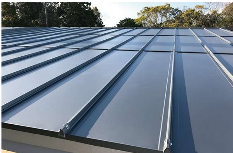
図 4 ジョイント立平近景
