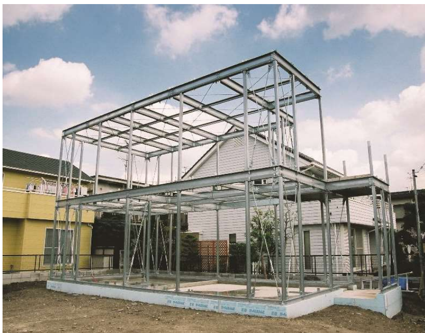
図 6 フレームキット施工例
