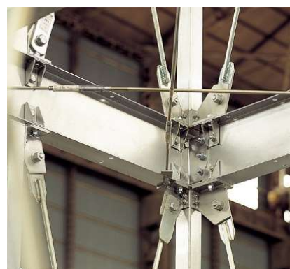
図 7 柱梁接合部
