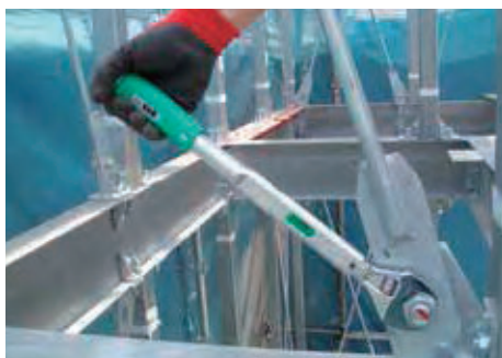
ブレース端部のボルト締め
