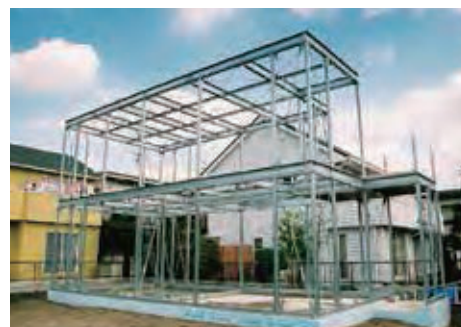
鉄骨建方完了
