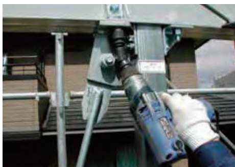
柱－梁結合部のボルト締め
