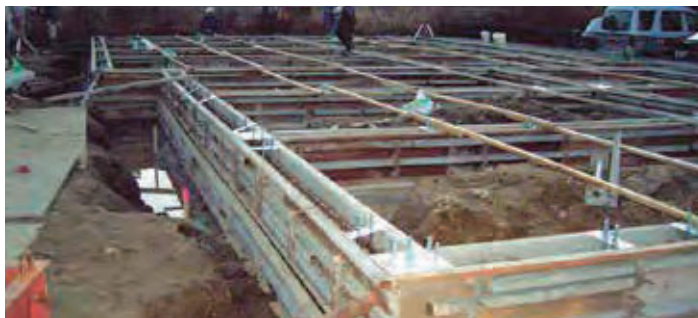
アンカーボルト取付け
