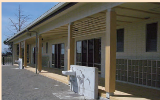
中庭を望むテラス
