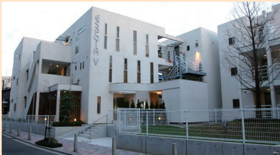
耐火建築物:3階 (1,525㎡)
