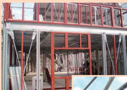
鋼製下地(サッシ開口)
