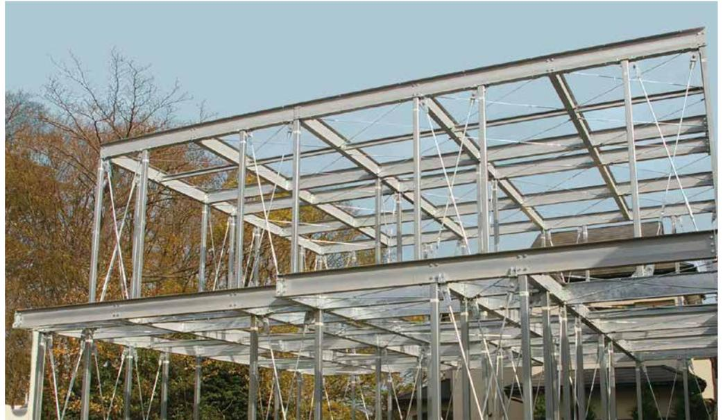
フレームキットは、鉄骨部材、各種マニュアル、専用入力ソフトおよび構造計算・構造図面をセットで提供するシステム鉄骨です。建物概要と間取りを入力するとAI-FRAME<sup>®</sup>が平面計画と架構をバランスさせた理想的な骨組みを計算します。
