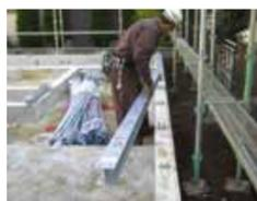
各部材は強度測定や耐力実験が行われており、安全性の高い鉄骨造建築を実現する。部材は発注から約40日で納品可能、建方は1週間で完了できる。共同住宅や店舗での用途であれば、早期開業で収入増につながる
